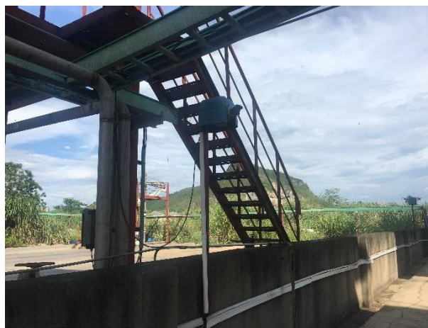
图 6 厂区内的视频监控系统
