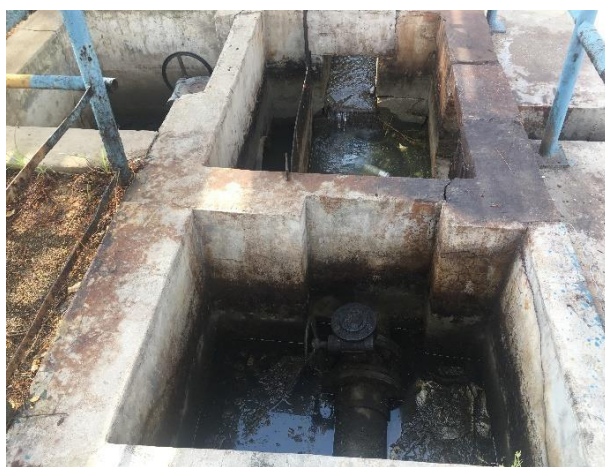
图 10 污水控制阀门
