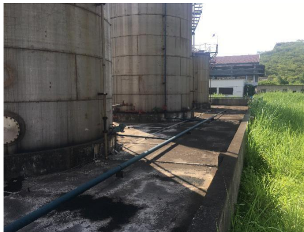
图 2 双氧水储罐围堰
