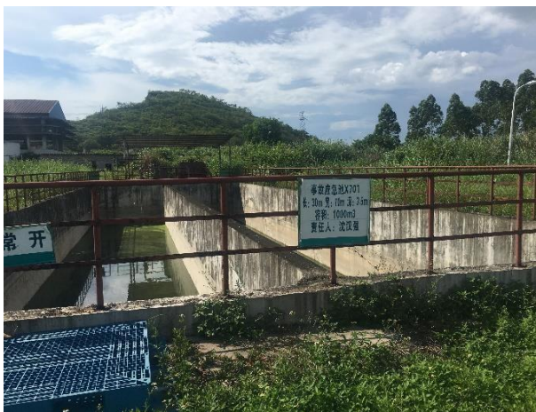
图 3 1000m 3 储罐事故应急池
