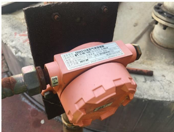
图 7 氢气气体探测器
