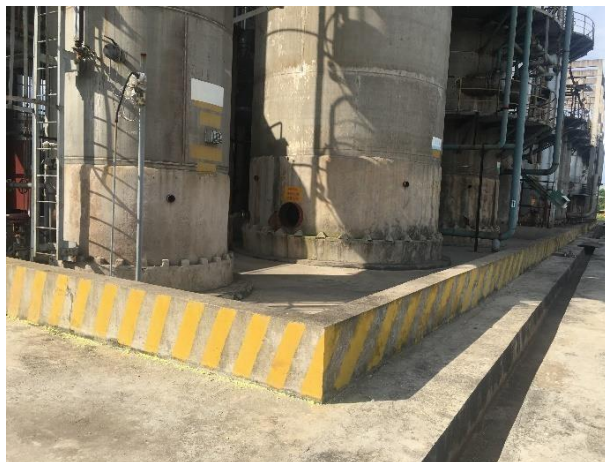
图 8 车间的围堰及雨水沟
